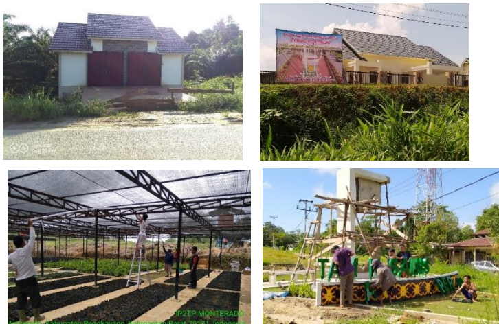
Gambar 111. Sebagian aktivitas pembangunan pada TSP Simpang Monterado, yaitu: market center, gedung kantor baru, pembangunan sistem irigasi modern, dan taman TSP.
