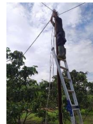
Gambar 66. Instalasi Jaringan Listrik
