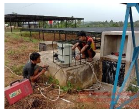
Gambar 65. Instalasi dan Pengamanan
