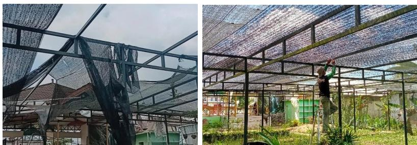
Gambar 23. Perbaikan atap Paranet Seed House di IP2SIP Sungai Kakap
